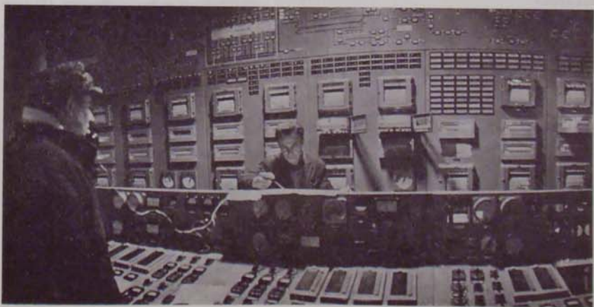
Lukomlszka Erőmű turbinaegységének vezérlőpultja
