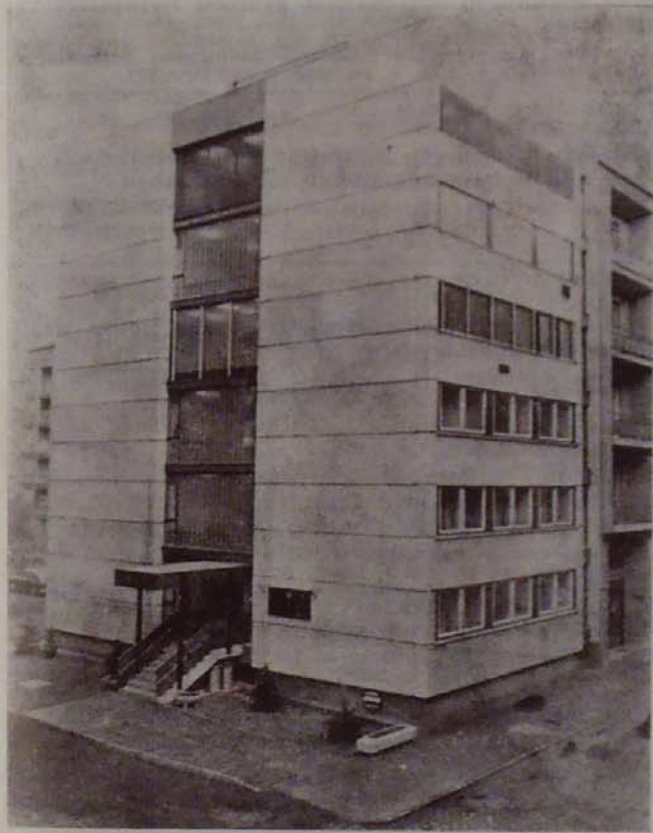
A pénzügyminisztérium számítóközpontjának épülete.
