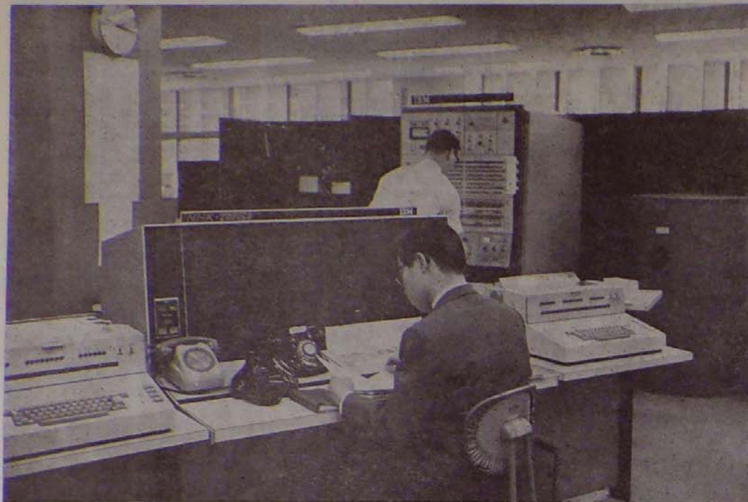
A japán rádió műsorait a TOPICS (Total On-line Program Information and Control System) információs és vezérlő rendszer irányítja. A rendszer központjában egy IBM 360/50-es és egy IBM 1800-as számítógép végzi az adatfeldolgozási műveleteket. A TOPICS két televízió- és három rádióállomás teljes műsorát és adminisztrációját szervezi.
