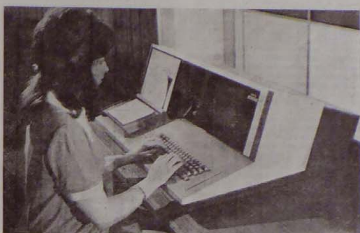
A Lamson Viatron Computer Systems Ltd. cég ANITA DET 3111 típusjelű adatbe- viteli berendezése. A billentyűzött adatok először képernyőn jelennek meg, majd mágnesszalagra rögzítik azokat.
