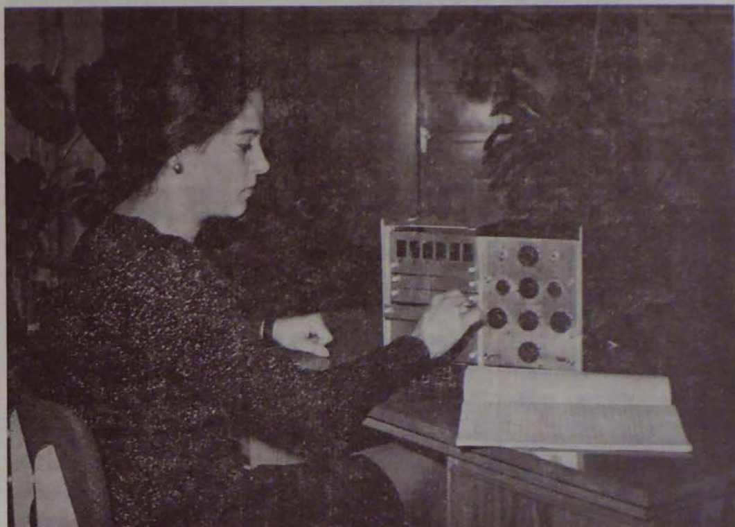
Képünkön hat sejtből álló sejtautomata látható működés közben. A készülékbe épített három ESZR kártya két sejt-áramkört tartalmaz. A sajátos „számítógép” kicsiben szemlélteti a sejtautomaták alapelvét, azt, hogy műveletvégzés közben minden sejt egyidejűleg működhet.
