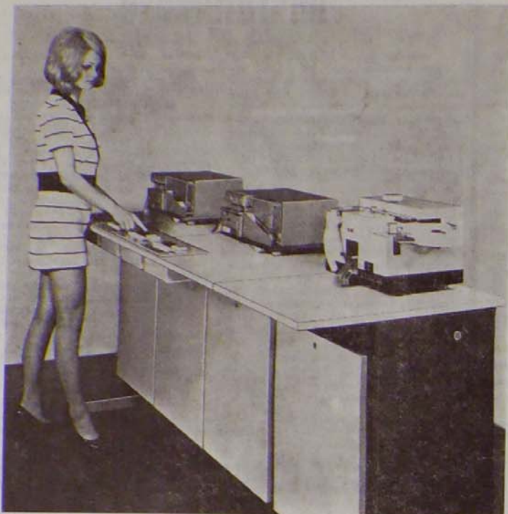
Az LBS (ESZ 7902) típusú lyukszalagállomás. A lengyel gyártású lyukszalag-lyukasztót és olvasókat NDK gyártású elektronika egészíti ki.
