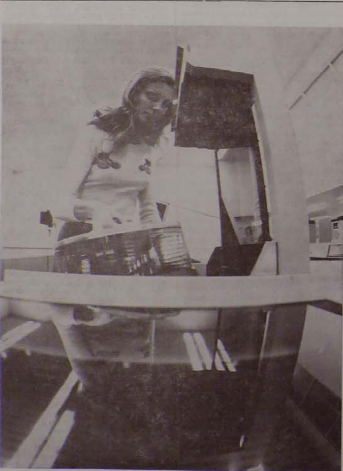
Az angol ICL legújabb 2900-as számítógépcsaládjának cserélhető mágneslemez egysége. Kétféle változatban készül 100 és 200 Mbyte tárolókapacitással.
