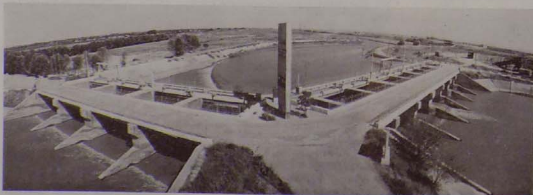
Igy néz ki a vízelosztó esomópont az üzbegisztáni Zavarsan folyón. A vízáramlást automatikus irányítási rendszerrel szabályozzák.
