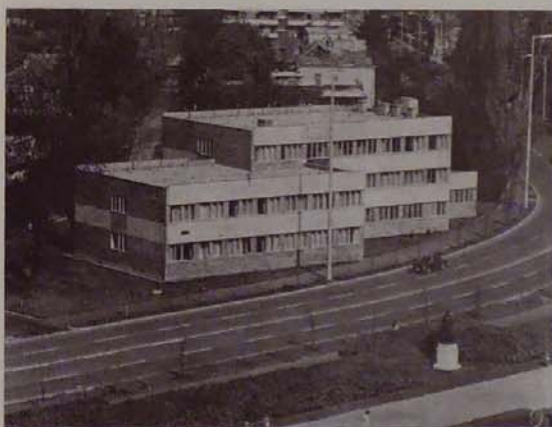
A SZÜV Debreceni Számítógéppontjának épülete (Foto: Iklódy János)
