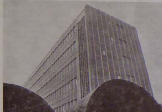
Az épülő oktatóközpont Wrocławban
