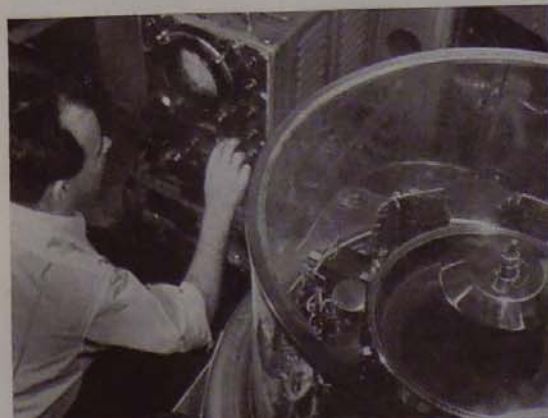
Rendszeres napi karbantartás-mérés a mágnesdobon
