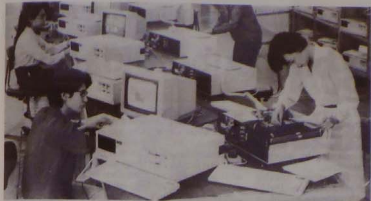
„Archív” kép Pekingből, 1987-ből. Great Wall—286 (Nagy Fal) típusú mikroszámítógépeket szerelnek a Kínai Számítógép-fejlesztési Vállalat gyártócsarnokában.
