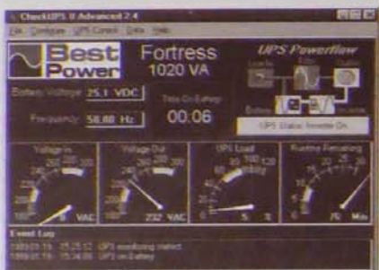
4. kép. Információ az UPS-ről, a jobb felső sarokban az áramút
