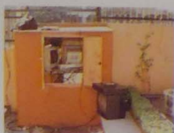
Az első kioszk építése közben
