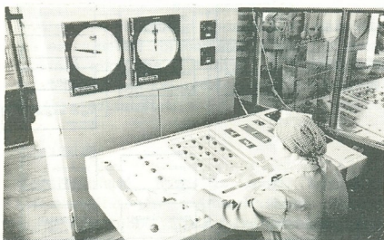
4. ábra: Betongyári elektronikus mérlegrendszer vezérlőpultja
