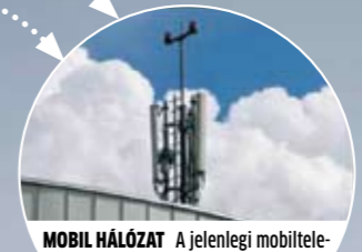
MOBIL HÁLÓZAT A jelenlegi mobiltelefonos hálózaton forgalmi adatokat továbbíthatunk GSM és UMTS segítségével
