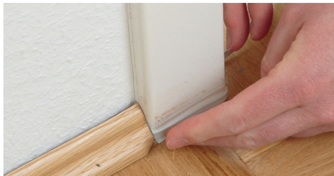
Ha nem túl szűk a hely, akkor még az ajtók alatt is átbújtható a szalagkábel, csak használjunk a falával egyező színű ragasztószalagot az elrejtéséhez
