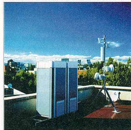
A Nokia Ultra Site egyszerre kezeli a GSM, EDGE és WCDMA rendszereket
