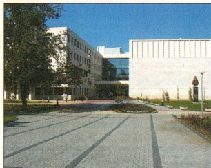
A hallgatói információs központot a HP intelligens épületmenedzsment megoldása vezérelti
