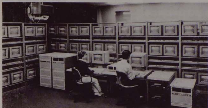
A Siemens karlsruhei gyárában mikroszámítógépek bevizsgálására SICOMP M/6680-as, általános célú számítógépet használnak, amelyhez egyidejűleg 54 képernyős munkaalomlás csatlakoztatható. Hálózatkimaradás esetén a tárolt adatokat a rendszer megőrzi, az eredeti munkaállapotot és a képernyőtartalmat néhány másodperccel a hálózatkiadás után automatikusan helyreáll.
