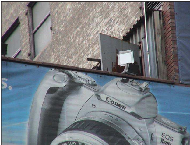
5. kép Egyetlen tetőantenna szolgálja ki a City Hall Parkot
