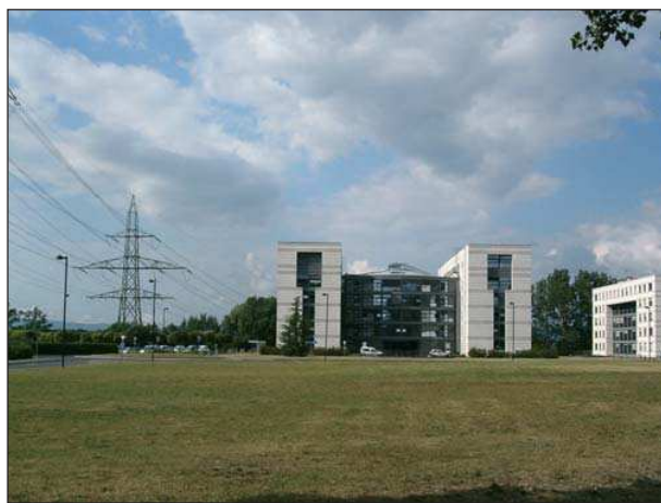
1. kép CERN legújabb épülete, mellette az irodák, gépteremek villamos betápjá
