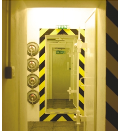
Kinyílt a belső zsilipajtó. A küszöbön látható, milyen vastag a fal. Az ajtó mellett nyomáskiegyenlítő szelepek láthatók
