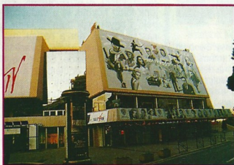
A Fesztiválpalota áprilisban a televíziós, videós szakembereket fogadta
